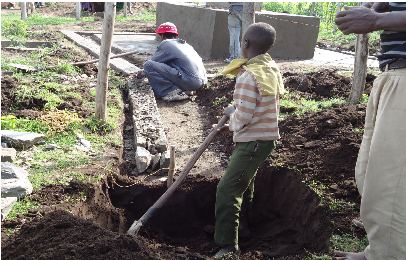
Výkop pro potrubí.
